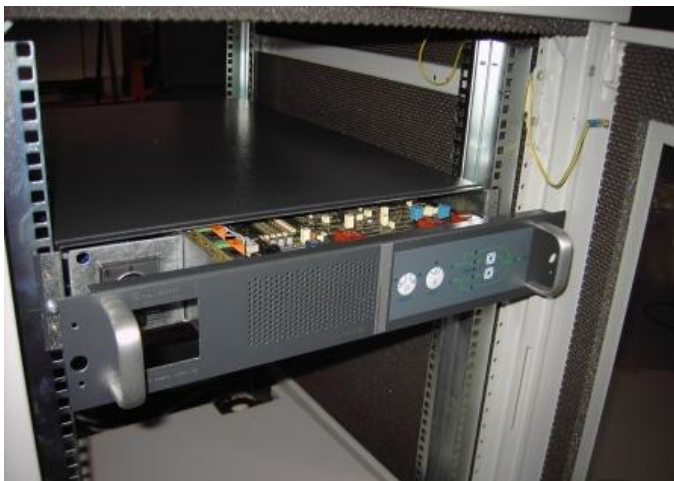
Rysunek 13 –Wyciąganie modułu statycznego
