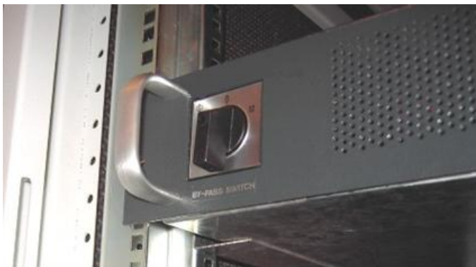
Rysunek 8 –przełącznik CHLORIDE CROSS RACK zamontowany na prowadnicach
