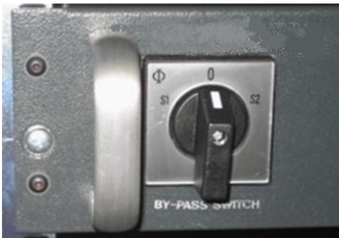
Rysunek 11 – Wyłącznik obejścia by-pass QS1
