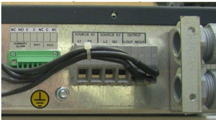
Rysunek 9 – Tabliczki zaciskowe i sygnał (zabezpieczenie rozmontowane)
