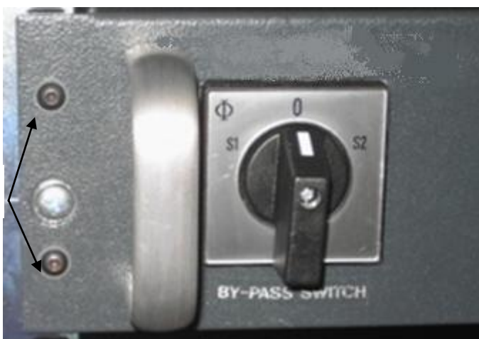
Rysunek 14 – Sruby mocujące moduł (2 z 4)
